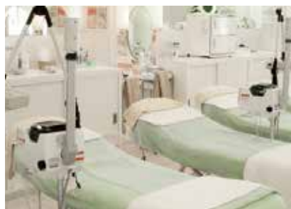
名古屋/サロン 躯体壁面全面へ電磁波シールド材料 として施工
