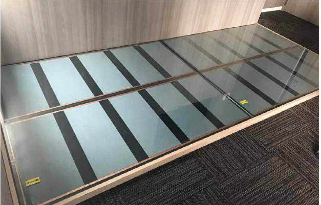
▲床部施工事例
