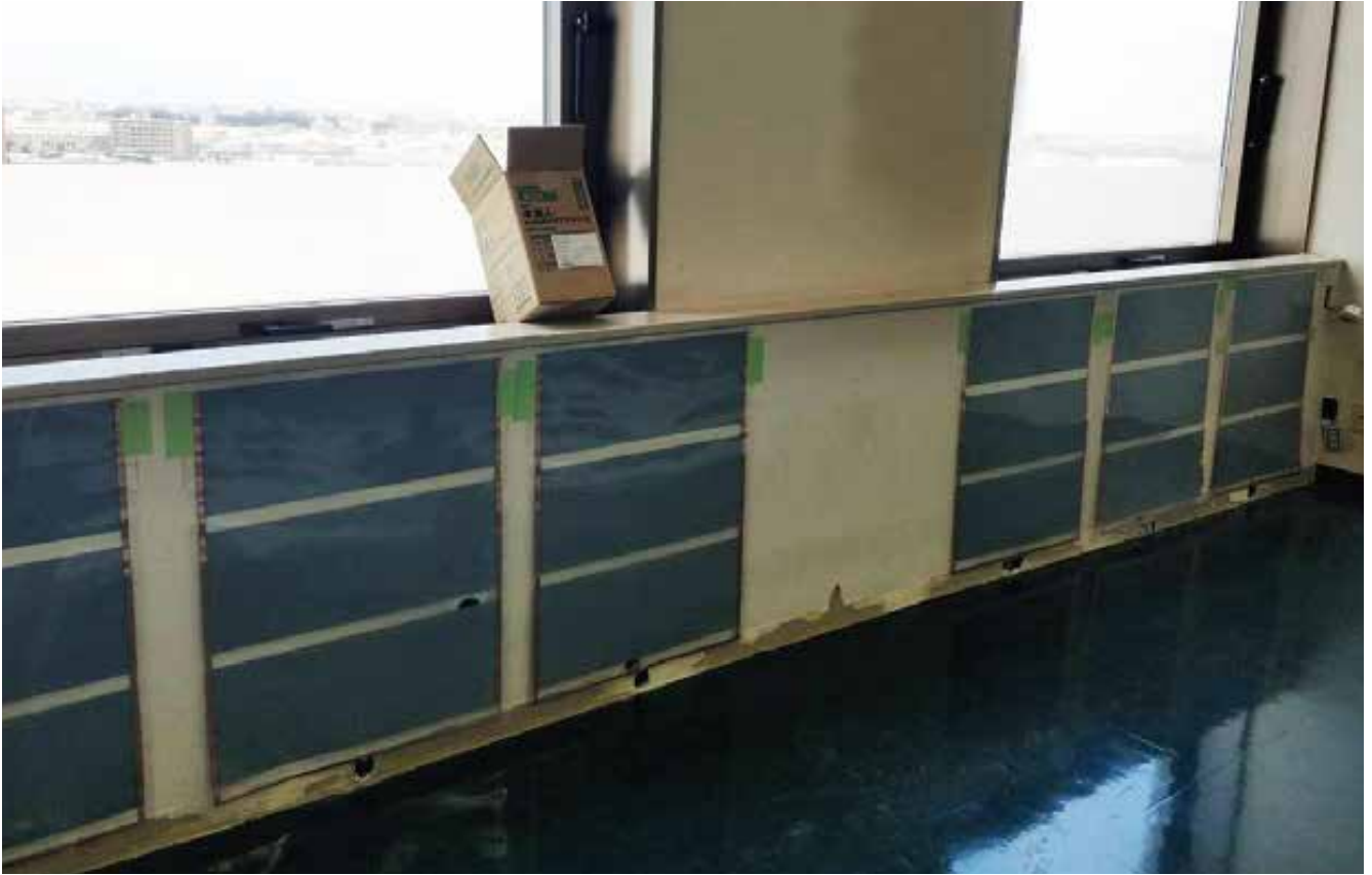
▲壁部施工事例(北海道)
